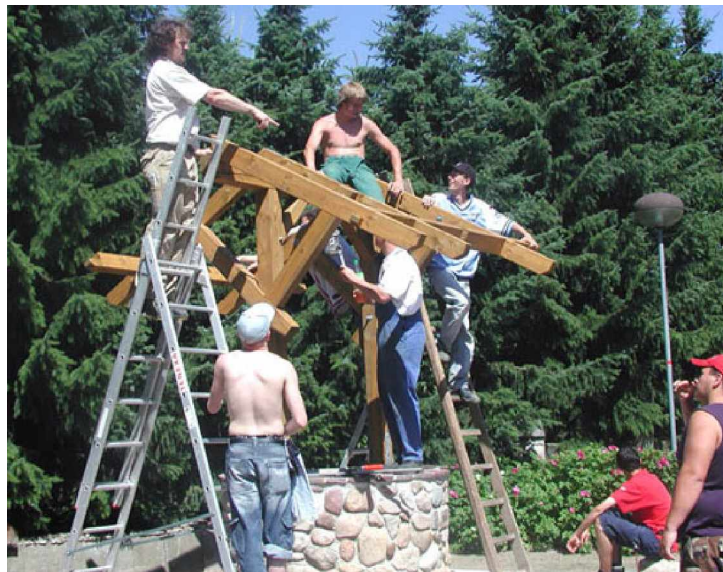
Aufbau der Holzkonstruktion
